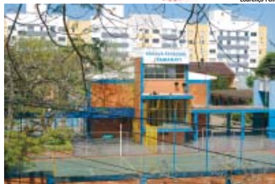
Vista da Escola Estadual Itamarati
